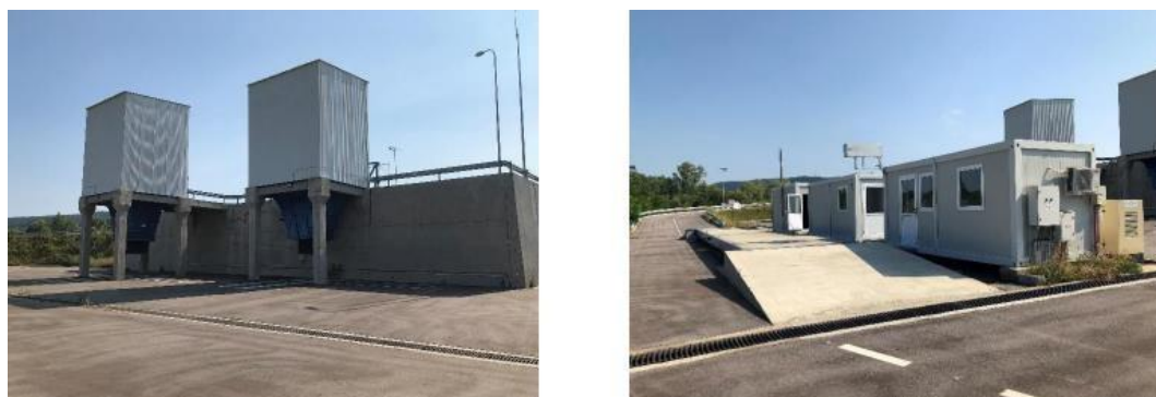
Figura nr. 17 –Stația de transfer Strehaia
