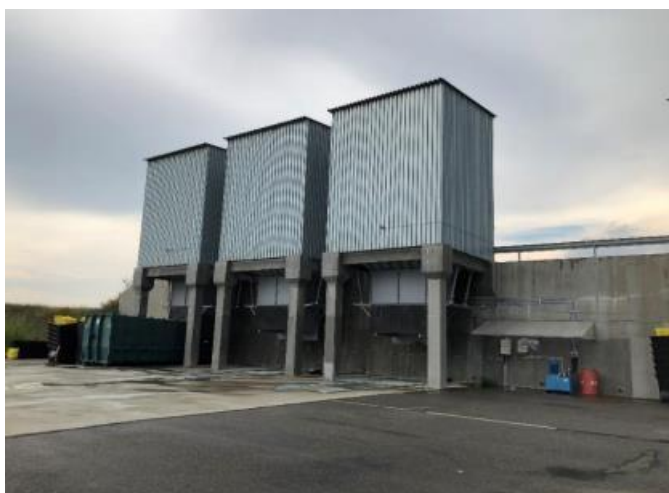
Figura nr. 18 –Stația de transfer Vânu Mare
